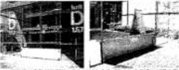
無断室の自動ドア材料に取り付けた止水パネルによる湧水対策の例
