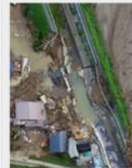
大雨で決壊した川の堤防＝12日午前、岡山県倉敷市真備町地区（小型無人機で撮影）
